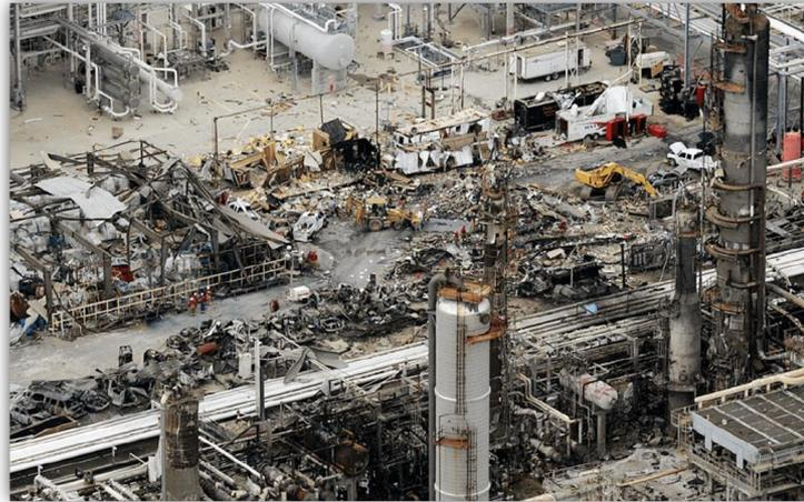
L'incidente, sviluppatosi nell'impianto ISOM a causa della perdita di contenimento di idrocarburi liquidi infiammabili da una torre fredda di abbattimento, ha provocato un VCE, notevolmente accelerato dalla congestione dell'impianto, portando a una serie di incendi e ad effetti di sovrappressione oltre il perimetro della raffineria.
